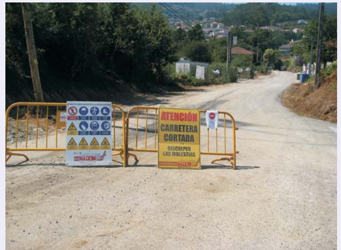
Señalización de las obras
