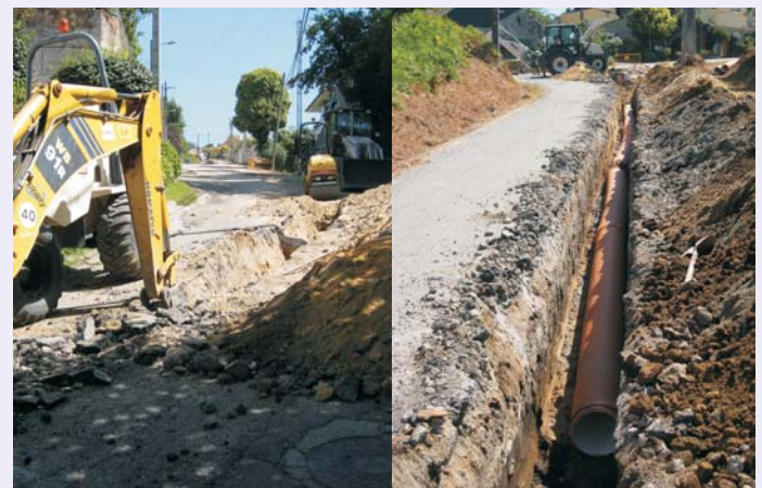
Excavación de zanjas.
