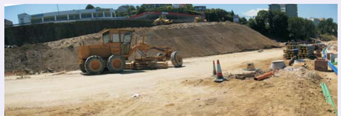
Extendido y compactación de tierras.
