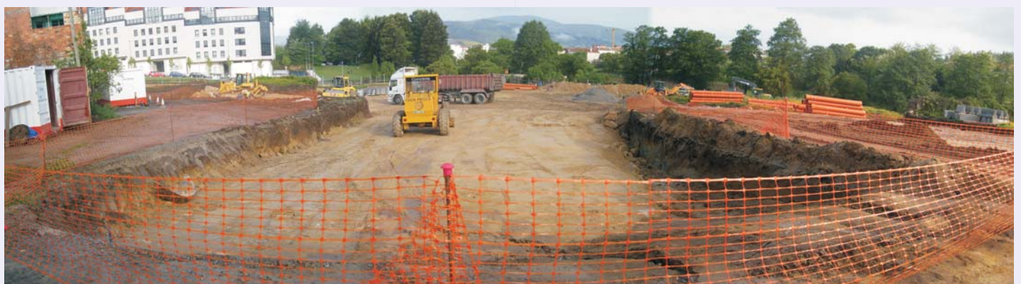
Excavaciones durante el desarrollo de las obras.
