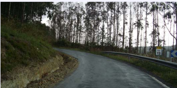
Estado actual DP 8901 PK 2+30 y DP 1802 PK 12+000.
